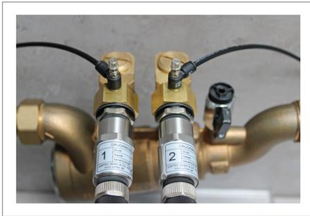
4. Schließen Sie die eingangs- und ausgangsseitigen Wartungsabsperrungen (Bild 1 Nr. 1 + 2). Der Systemtrenner ist nun von der Versorgungs- und der Verbrauchsleitung abgesperrt.
